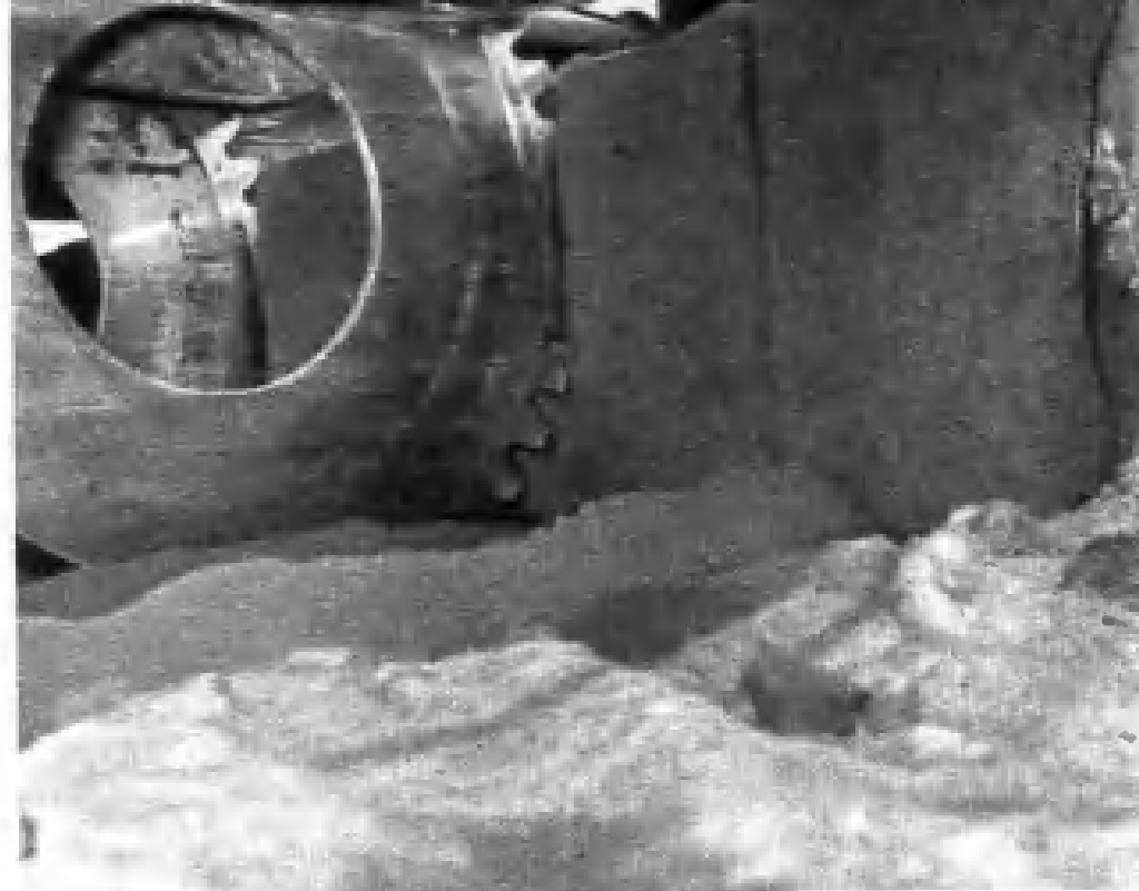
Каменнорезная машина Столярова нарезает уступ на крупные блоки.
